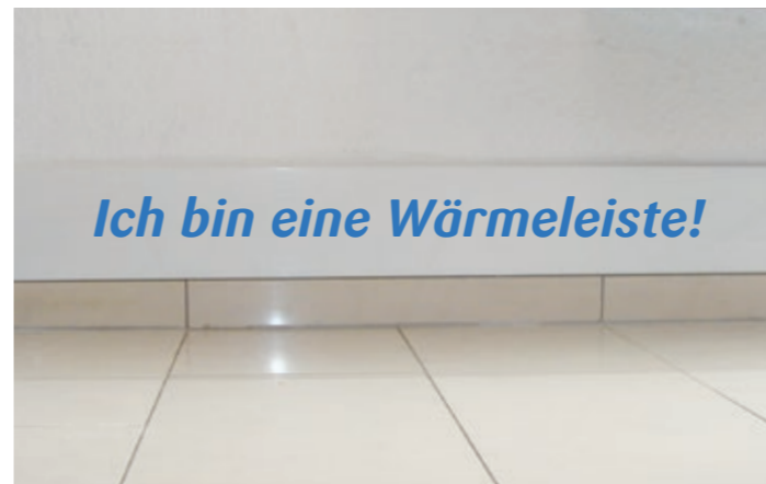
Infrarot-Wärmeleisten gewährleisten die Grundtemperierung des Raumes, verhindern aufsteigende Feuchtigkeit im Mauerwerk, trocknen dieses aus und entziehen Schimmel die Grundlage.
