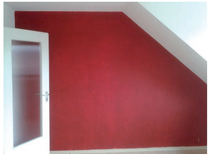
Die Heizkörpernische wird nicht mehr benötigt und kann verschlossen werden – die Wärme kommt zukünftig aus der Wand.
