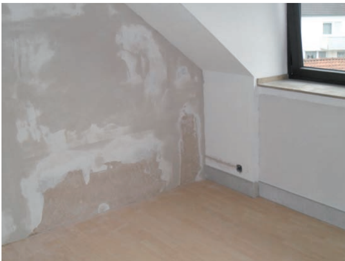
Die Heizkörpernische wird nicht mehr benötigt und kann verschlossen werden – die Wärme kommt zukünftig aus der Wand.
