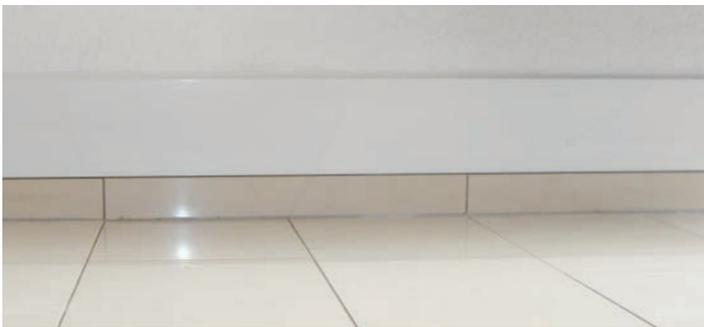
Die Infrarot-Wärmeleisten gewährleisten die Grundtemperierung des Raumes, verhindern aufsteigende Feuchtigkeit im Mauerwerk, trocknen dieses aus und entziehen Schimmel die Grundlage.
