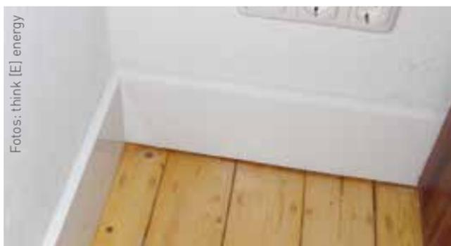
*Spezielle Wärmeleiste können an Stellen angebracht werden, wo das Gebäude Schwachstellen aufweist (Balkon) oder wo etwa Schimmelwachstum hinter Schränken befürchtet werden muss.*
